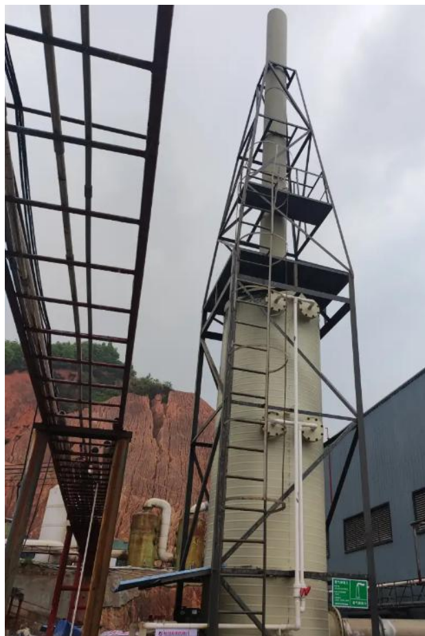
DA007 废气治理设施照片（水喷淋）
