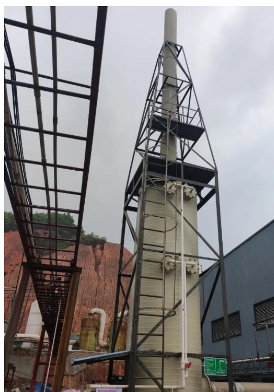
DA007 废气治理设施照片（水喷淋）
