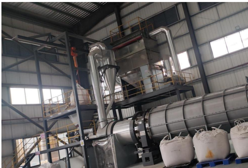
DA007 废气治理设施照片（旋风除尘+布袋除尘）
