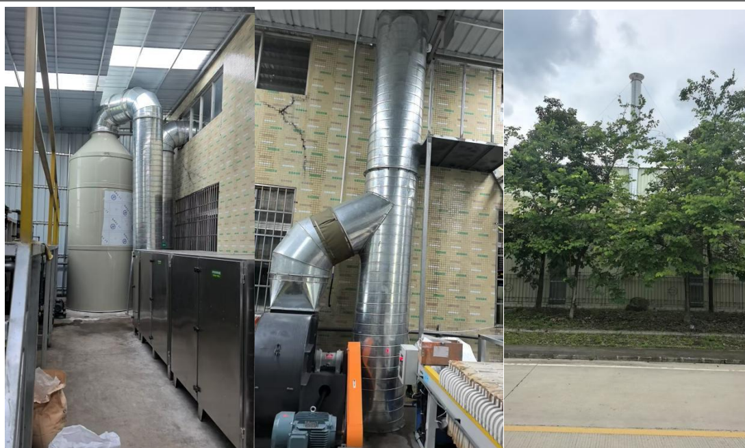
DA001 废气治理设施照片（水喷淋+干式过滤+二级活性炭）
