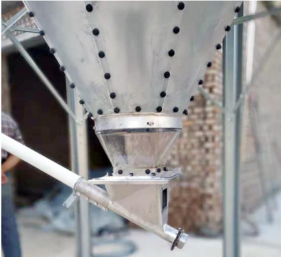
图 3-7 料塔出料口（与输料管线的进料口连接）
